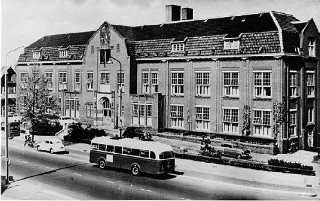
Het ORKZ als Rooms-Katholiek ziekenhuis
