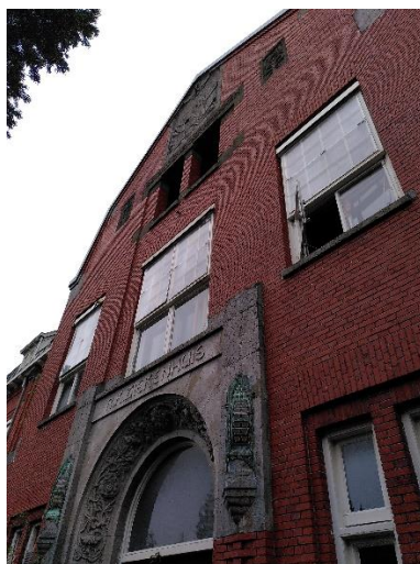
De monumentale voorgevel is lastig te verduurzamen
